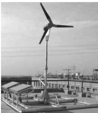
図13 太陽光発電/風力発電のハイブリッドシステム
