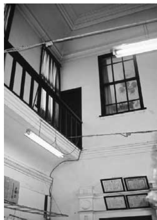
図7-2 内部吹き抜け
