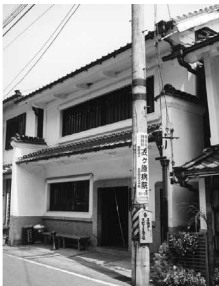
図5-1 旧稲橋銀行足助支店外観
